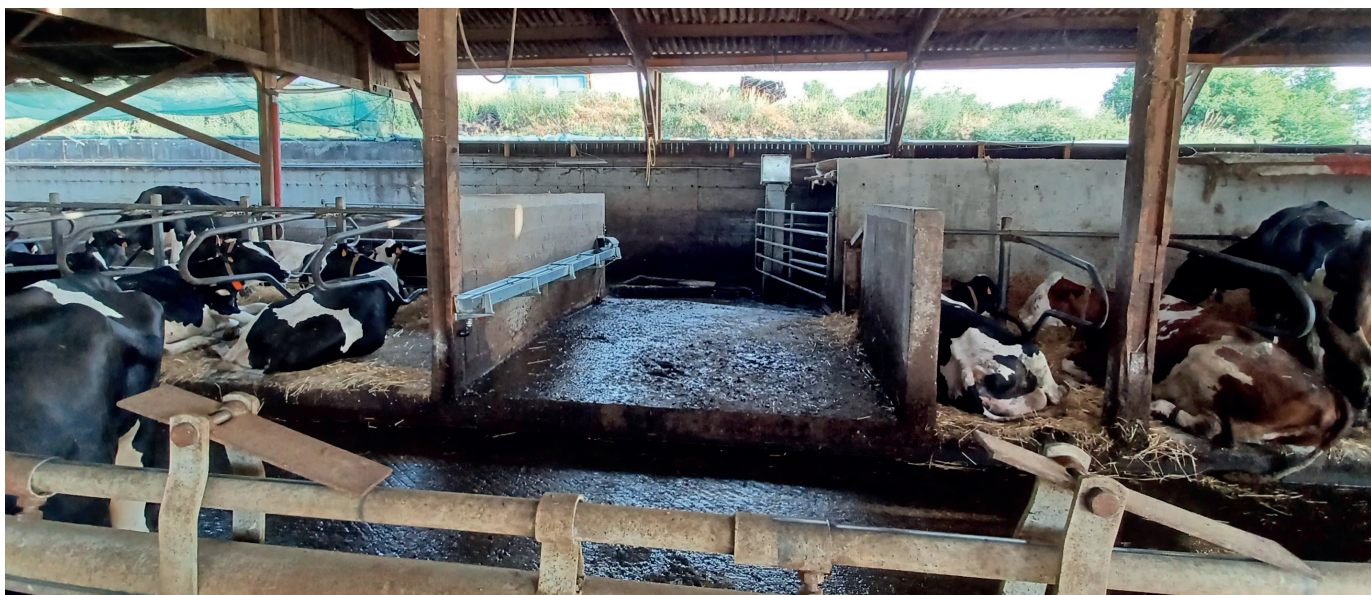
Photo 7 - Installation de nouveaux abreuvoirs
