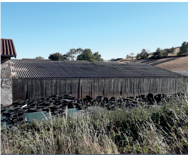
Photo 19 - Bardage fixe avant installation des volets
